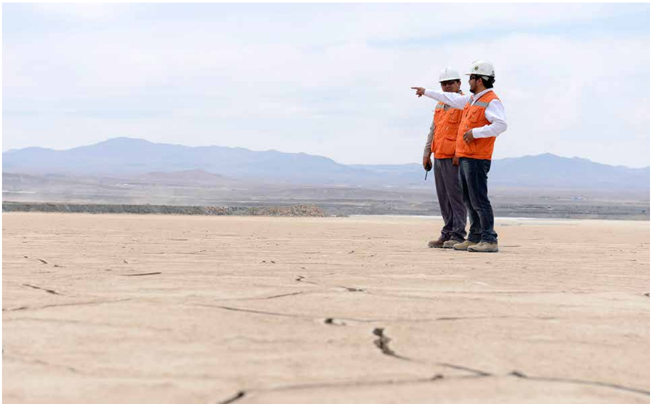
Depósito de relaves espesados, Minera Centinela.
