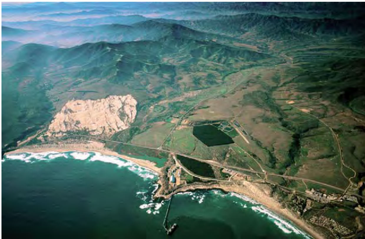
Los Pelambres port facility at Punta Chungo.
