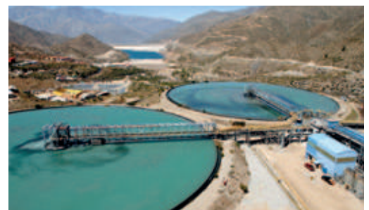
The tailing thickeners at Los Pelambres.
