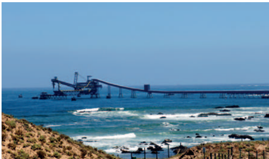
Punta Chungo port at Los Pelambres.
